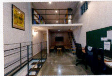
工場内事務所 改修
